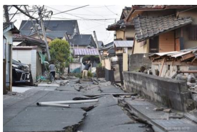
熊本震災後のまち並み
