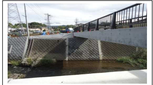
伊豆島田橋より撮影 三島市側の工事は始まっています。
